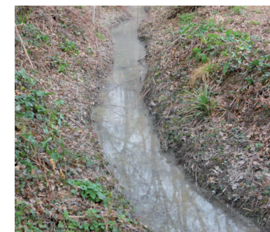
Lit mineur après intervention
